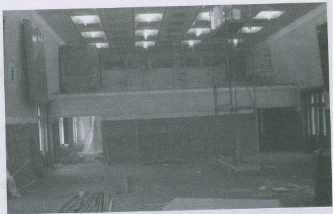
A díszterem felújítás közben
